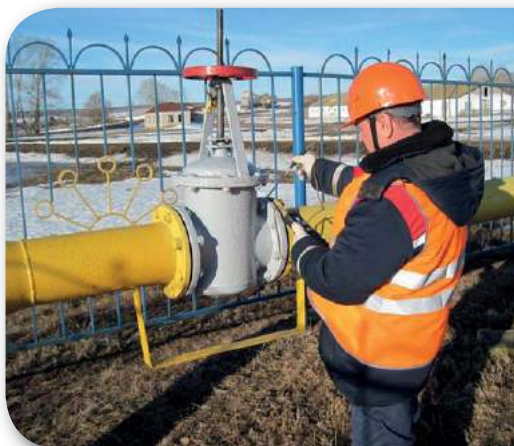
Рис. 2. Работы по восстановлению герметичности ТПА
