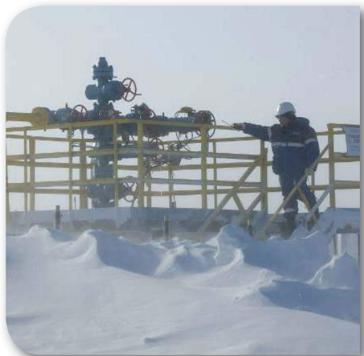
Бованенковское месторождение: Фонтанная арматура на кустах газовых скважин
