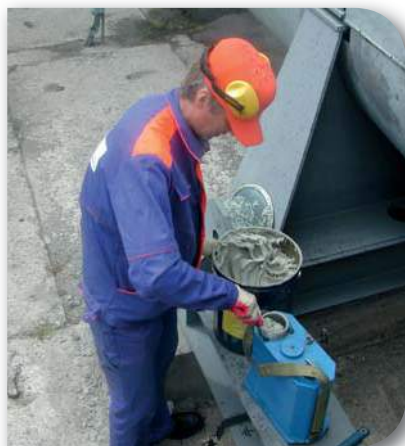
Рис. 2. Работы по восстановлению герметичности ТПА
