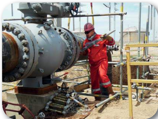
Рис. 1. Опытно-промышленные испытания уплотнительной пасты «Гермокор»
