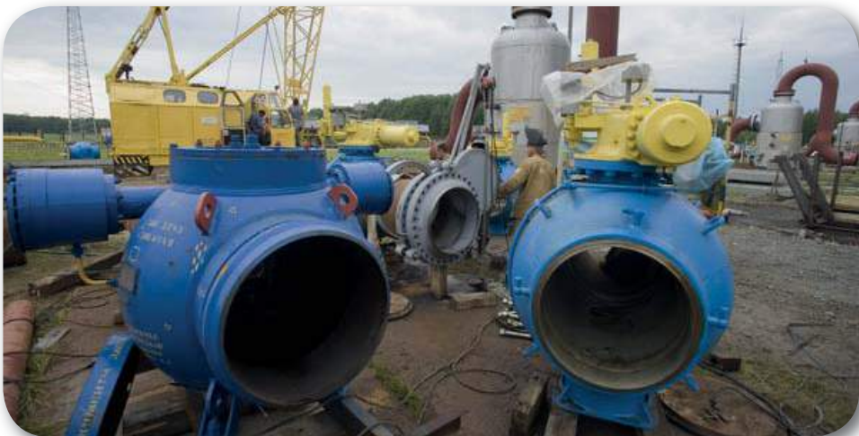
В ООО «Газпром трансгаз Сургут» наработан опыт повторного применения шаровых кранов
