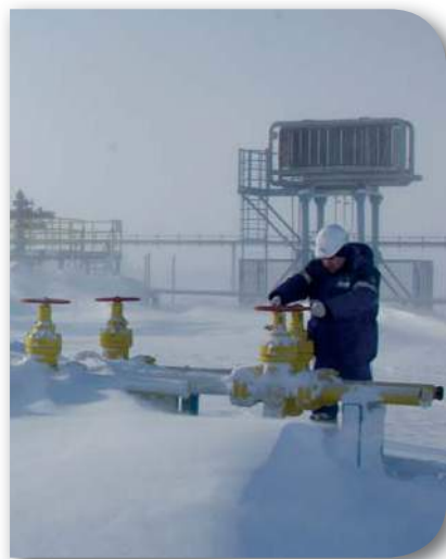
Бованенковское месторождение: Фонтанная арматура на кустах газовых скважин
