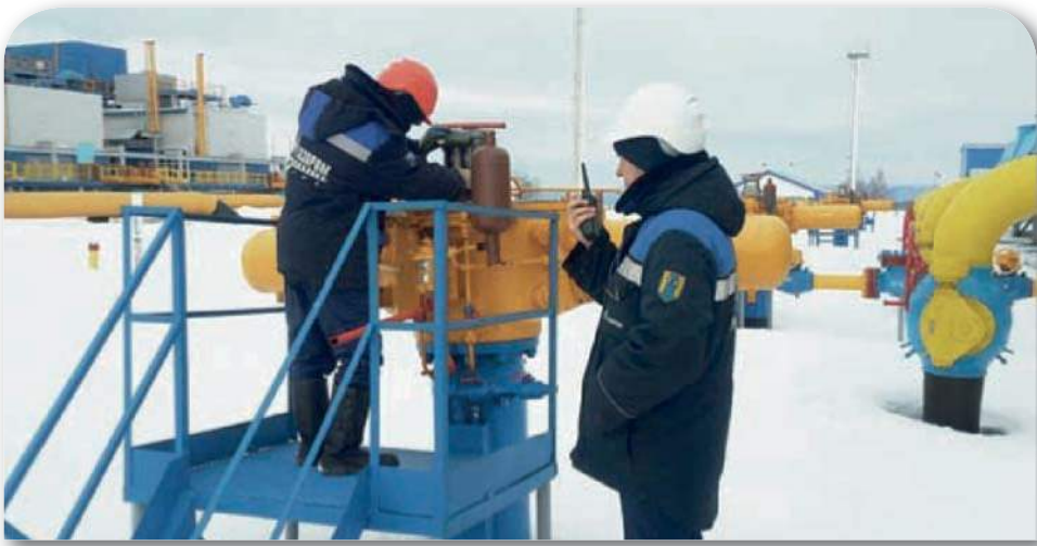
Рис. 3. «Газпром трансгаз Уфа». Подготовка производственных объектов к эксплуатации во время весеннего половодья
